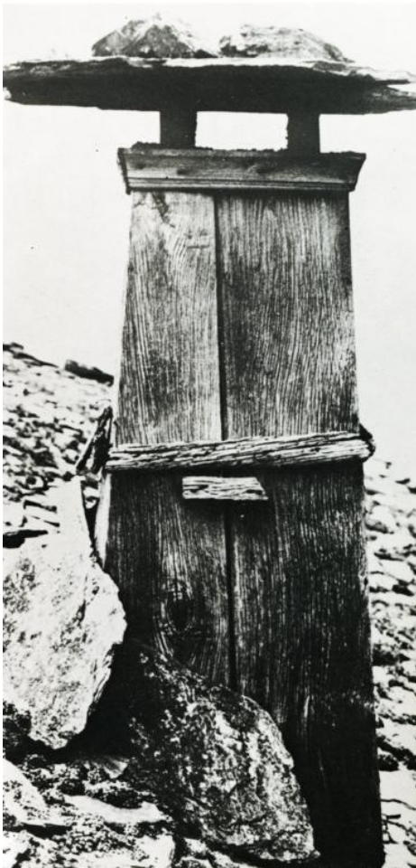
Chimenea de madeira con capa de xisto
